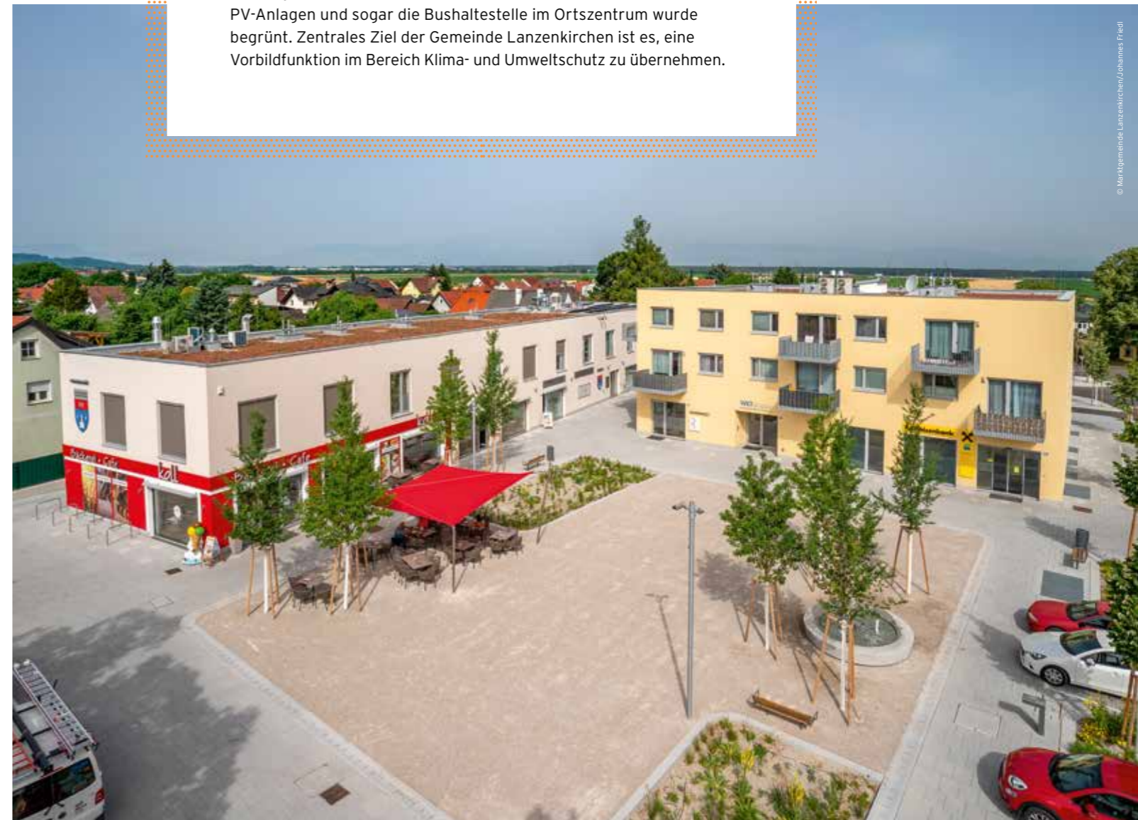
Das neue Ortszentrum in Lanzenkirchen kann mehr Wasser speichern und wird damit klimafitter.
