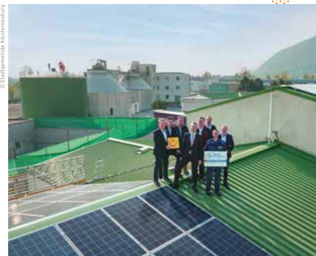
Vorbildhafte Kläranlage in Klosterneuburg
