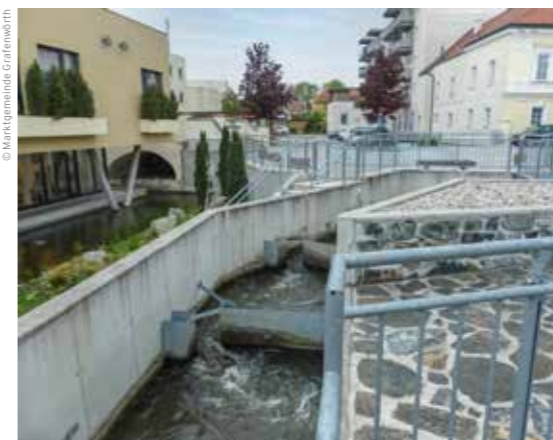
neugebautes Kleinwasserkraftwerk in Grafenwörth
