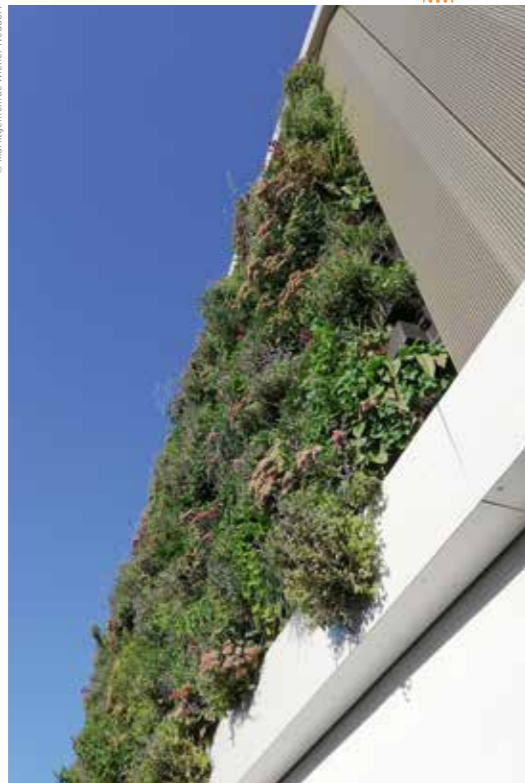
Fassadenbegrünung am Rathaus der Gemeinde Wiener Neudorf
