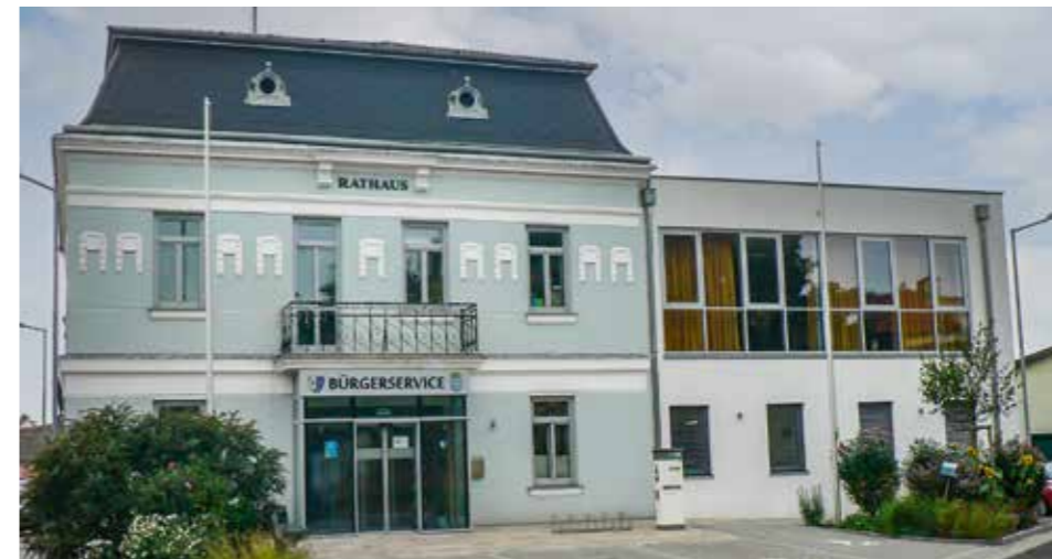
Im Rahmen einer Mustersanierung wurde das bestehende Rathaus von Absdorf thermisch verbessert und erweitert. Der Wärmebedarf wurde massiv reduziert bei gleichzeitiger Komfortsteigerung. Das Gebäude ist ein beliebtes Exkursionsziel.
