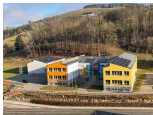
Von 2015 bis 2016 wurde das Schulgebäude der e5-Gemeinde Ertl umfassend saniert. Nun wird die Schule mit Nahwärme und seit dem Jahr 2020 auch mit Sonnenstrom versorgt.
